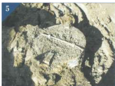
杭頭掘り出し状況
