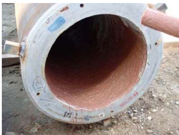
膨張剤塗布状況
