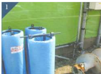
取付け前状況
