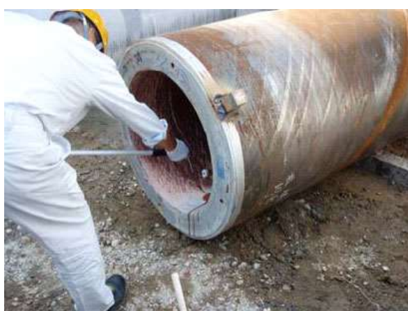
膨張剤塗布状況
