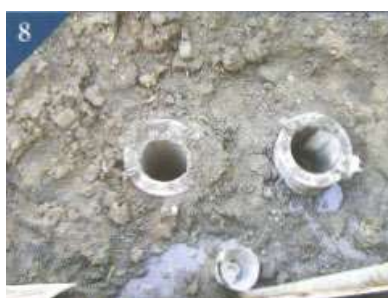
引抜き後状況
