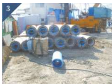
取付け完了状況
