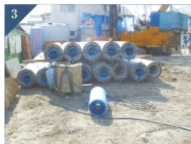
取付け完了状況
