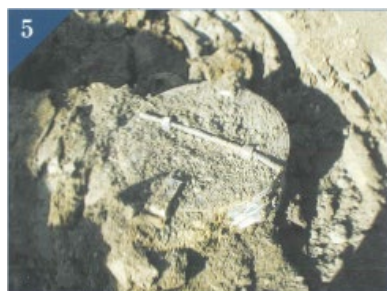
杭頭掘り出し状況
