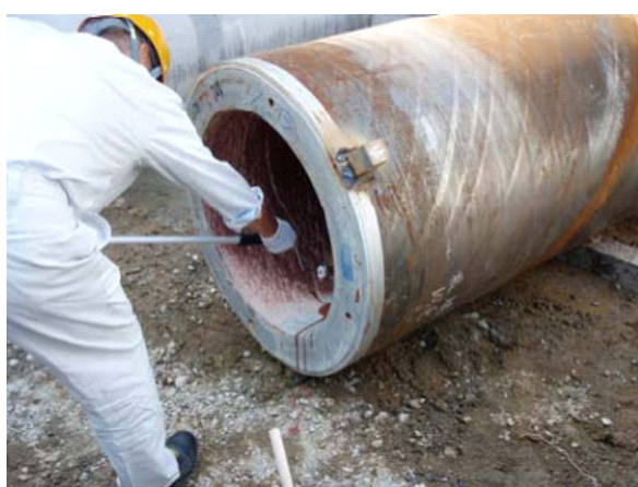
膨張剤塗布状況
