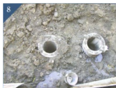
引抜き後状況
