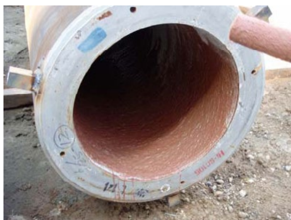
膨張剤塗布状況
